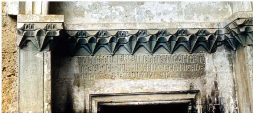
تصویر 40 - ورودی اصلی کلیسای نیچ در 1823 م پیش از عملیات مرمت و حفاظت با کتیبه های ارمنی بالای درب ورودی، که بعداً حذف شدند.
